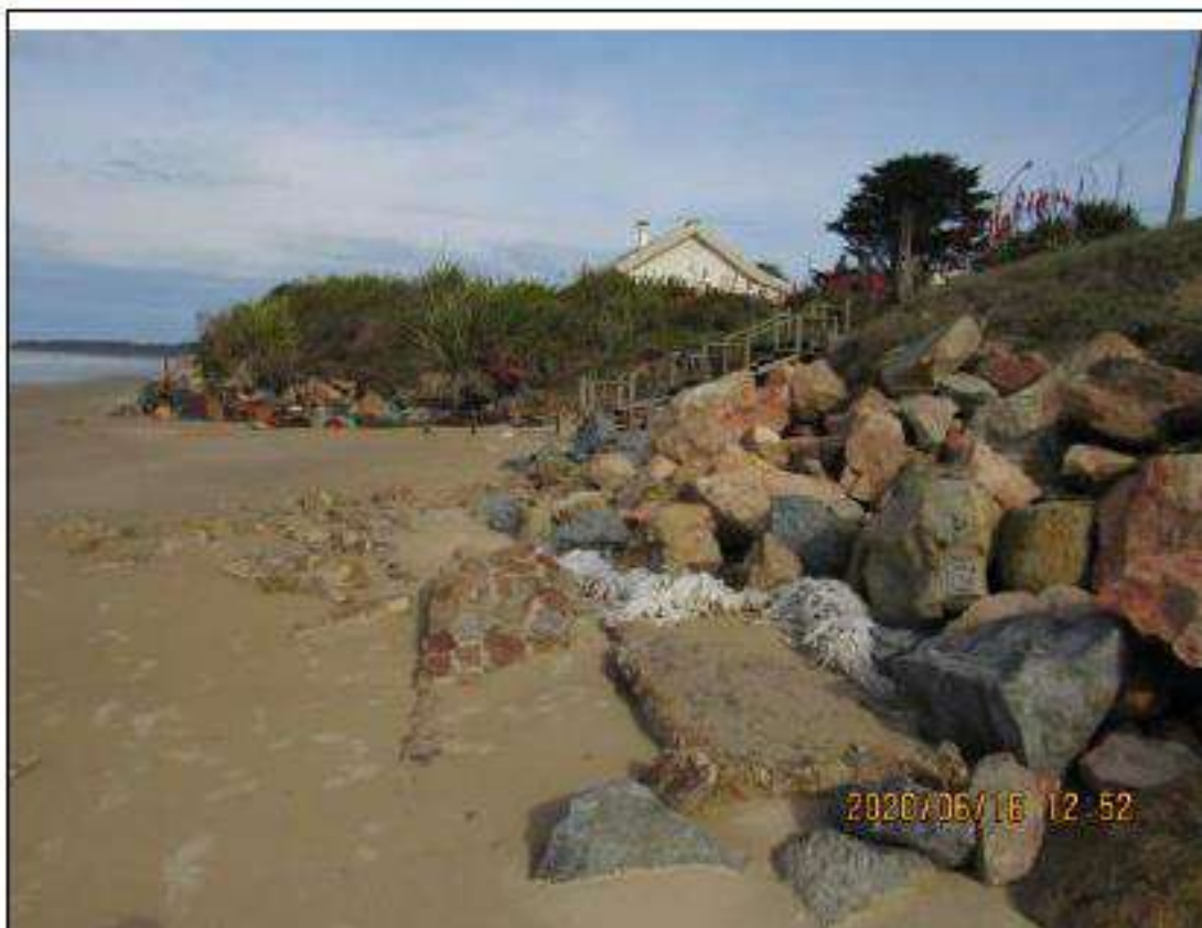
Ilustración 9: Enrocado de gran porte ingresando en zona de playa alta sin perspectivas de restauración. Nótese la distancia existente entre la construcción y la
